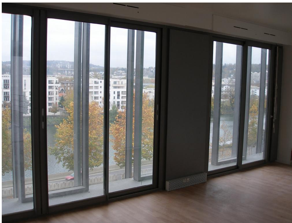
Vue intérieure : principe de double peau avec ventilation naturelle
