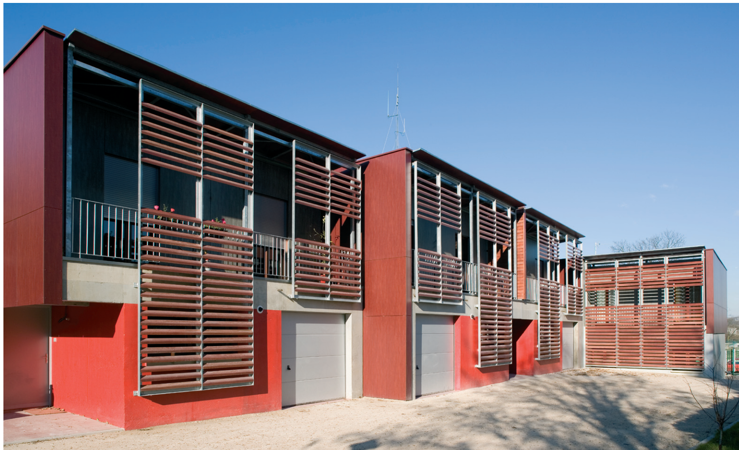
Vue extérieure, le coeur d'îlot, les brise soleil : pare-vues et garde-corps © Nicolas Borel
