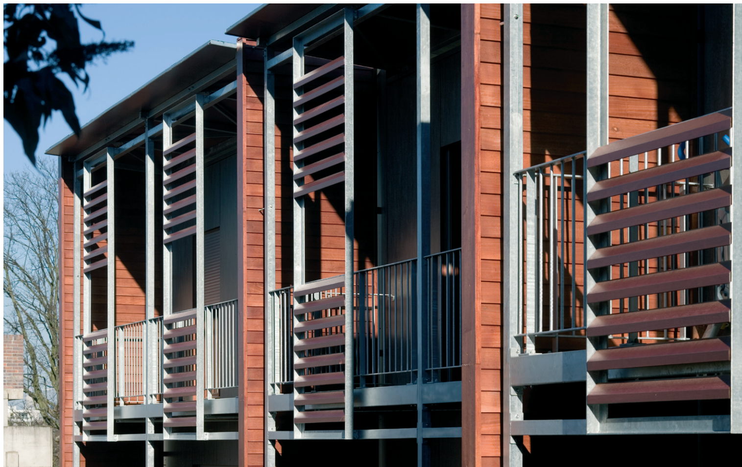
Détail sur les brise-soleil de la façade arrière © Nicolas Borel
