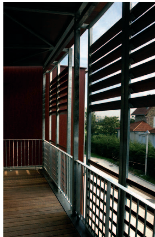
Vue depuis le balcon à travers le brise soleil © Nicolas Borel
