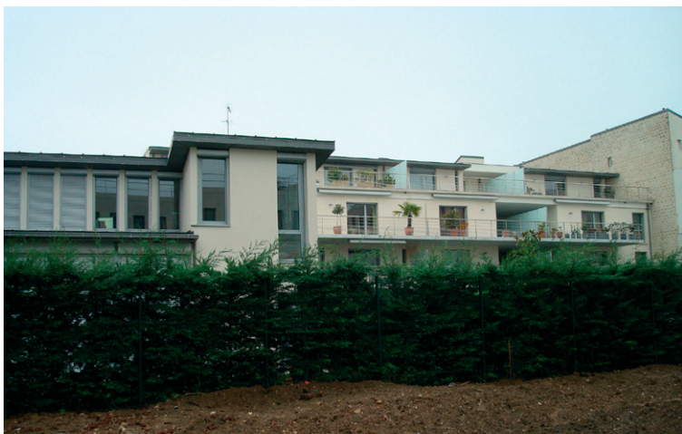
Vue de la façade arrière avec pavillon au 5-7 rue du Fossé © Christelle Lecoeur
