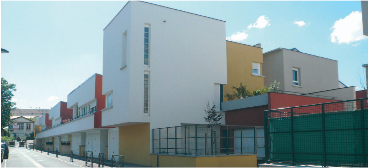
Vue de l'opération d'Edith Girard, rue de l'Espérance © Edith et Olivier Girard architectes
