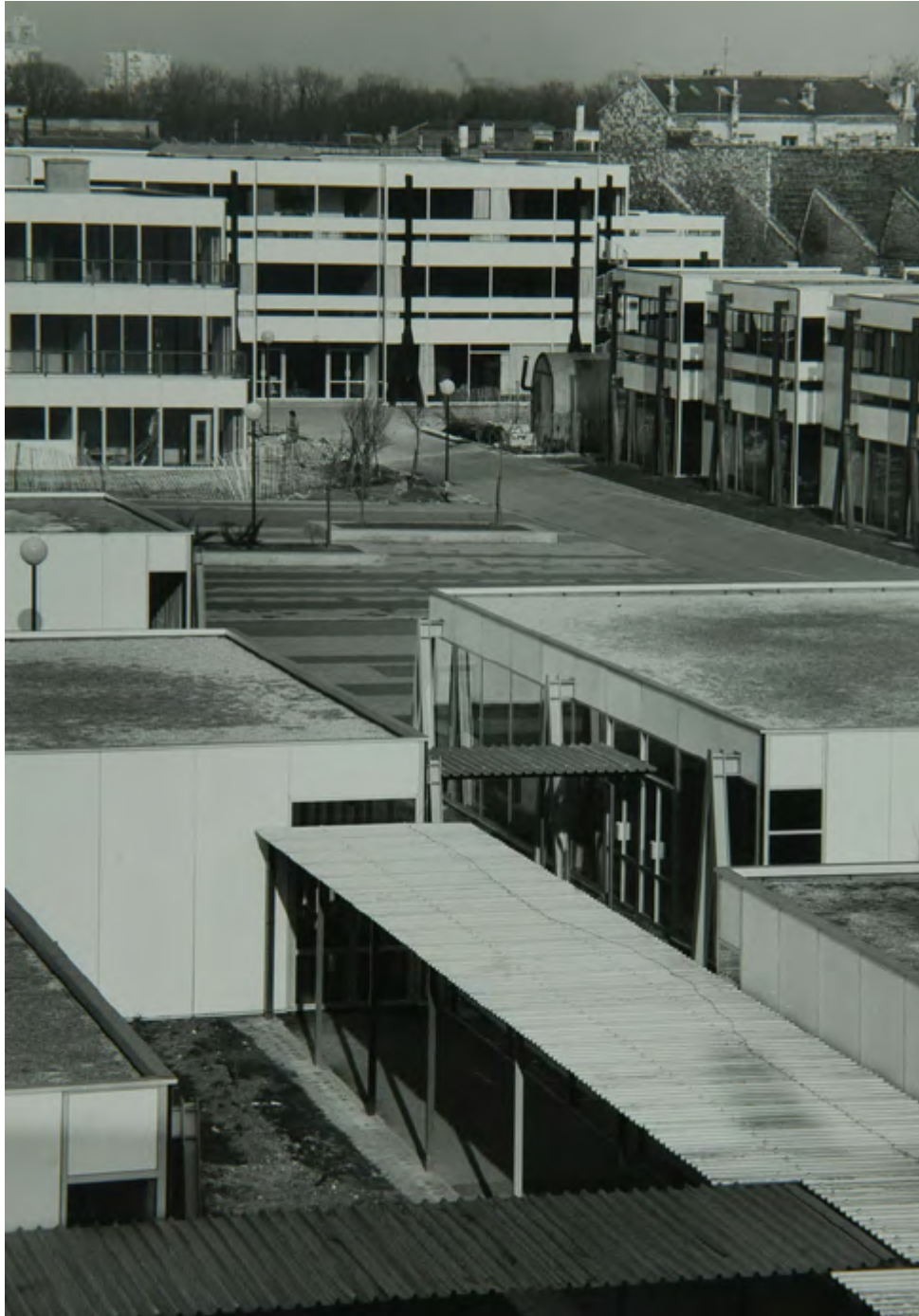
l'ensemble scolaire en cours de construction (vers 1970/71)
