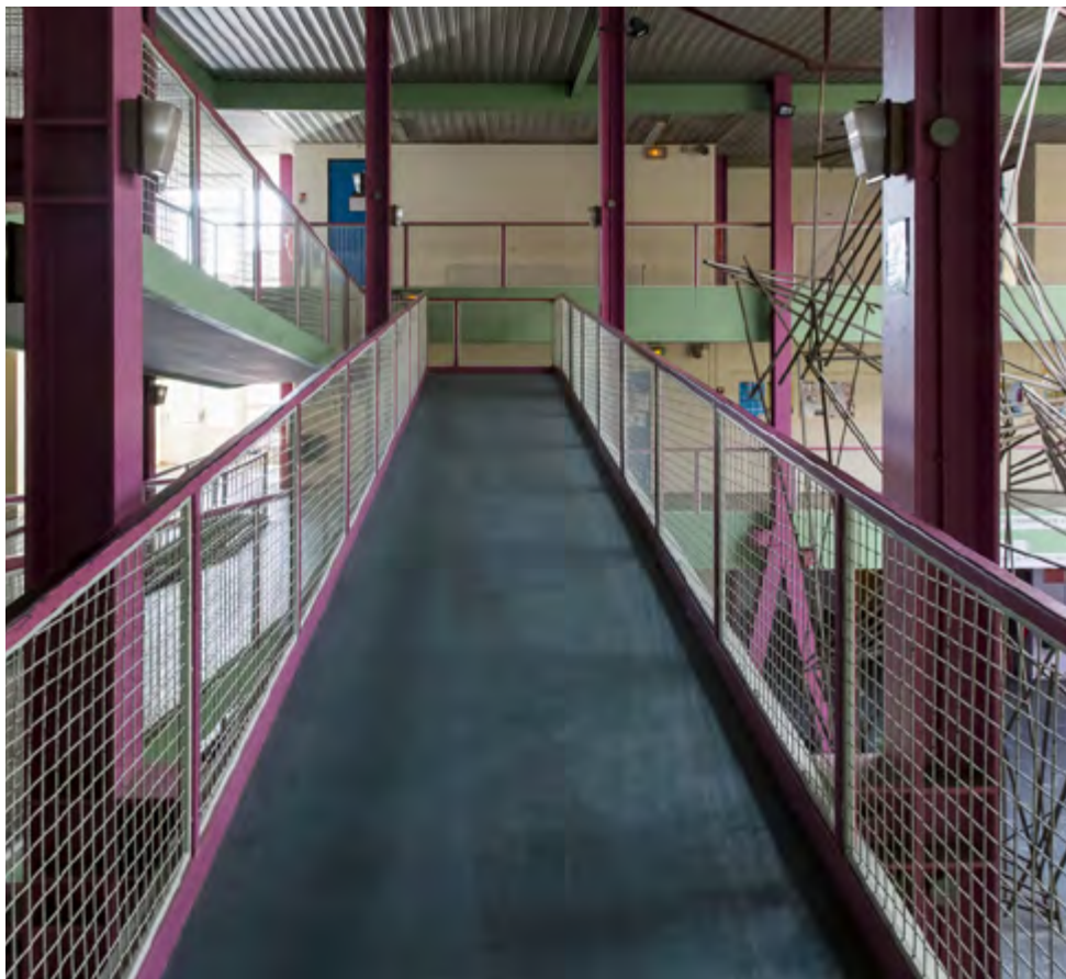
détail de la rampe du collège
