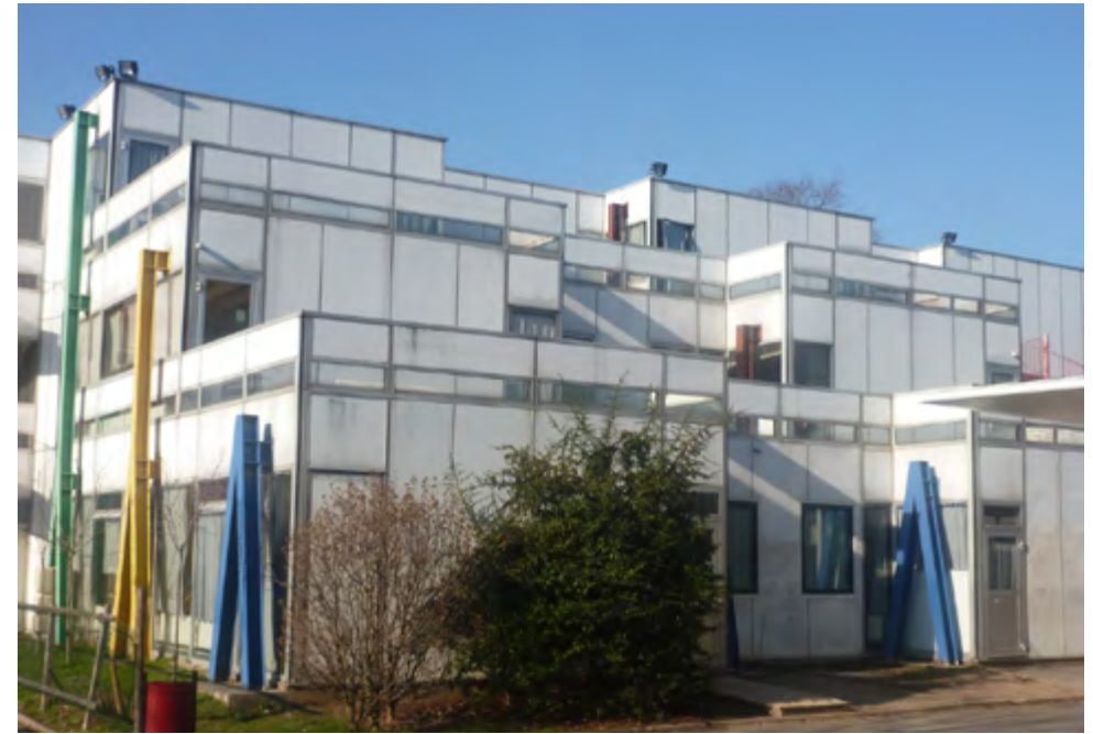
façade sud-est du collège
