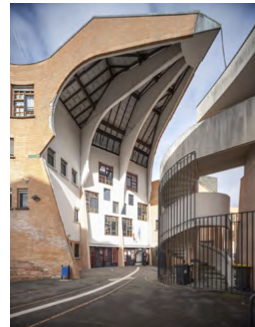
Entrée du collège sous le bec de la colombe
