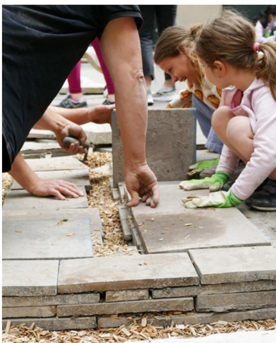
Construction d'un banc en asphalte de réemploi @ CAUE de Paris
