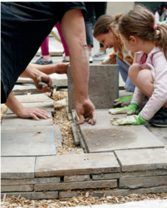
Construction d'un banc en enrobé de réemploi
