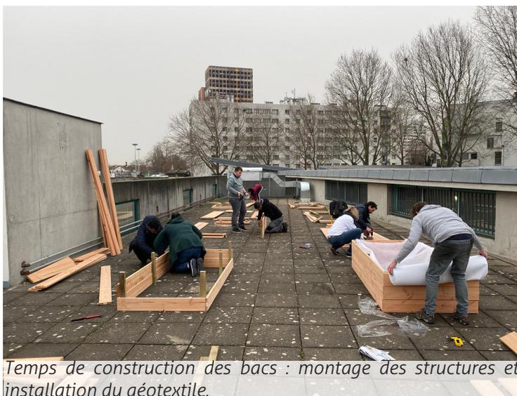
Temps de construction des bacs : montage des structures et installation du géotextile.
