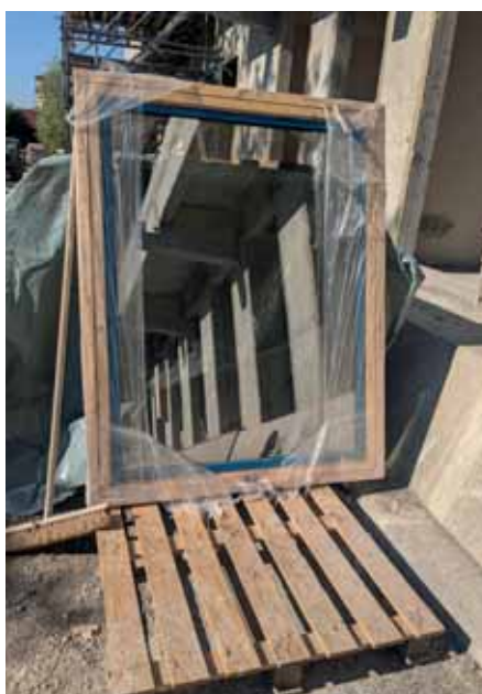
Photographies des phases de chantier-test en phase d'études pour le démontage des gisements in situ (gauche), témoin en phase chantier du châssis existant réemployé (droite)
