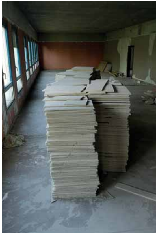
Photographie : dépose soignée en phase chantier de l'isolant en toiture (gauche), et stockage des dalles de faux-plafond (droite)
