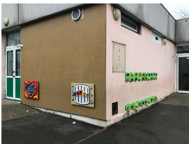
Ces murs sont équipés de prises d'escalade et de jeux sonores, également installés en 2024.
