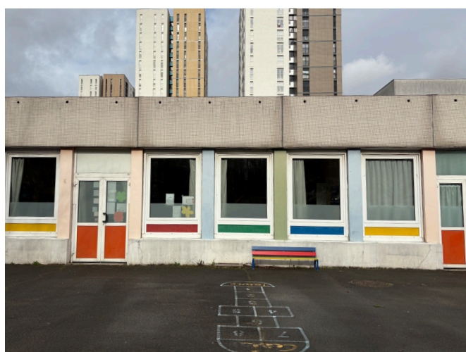
Vue de la façade de l'école permettant l'accès direct aux classes. Impossible d'y trouver de l'ombre en été.
