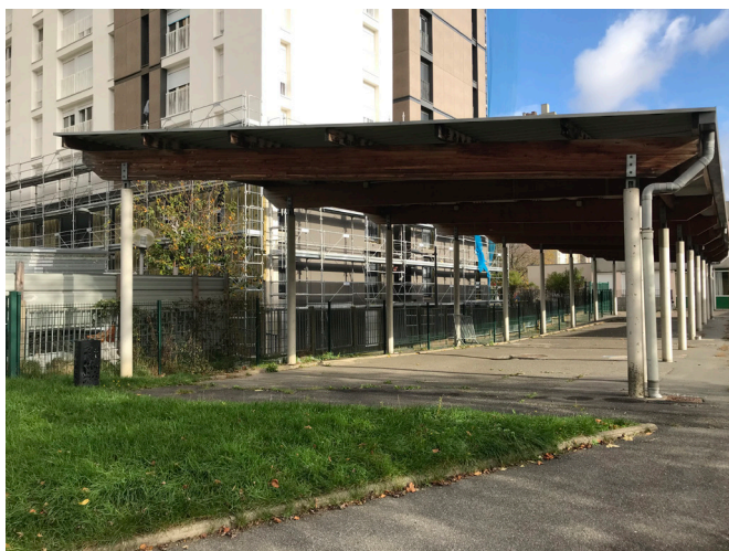
Le préau constitue un abri protecteur, non seulement face à la pluie et au soleil mais surtout contre les jets d'ordures depuis la tour.
