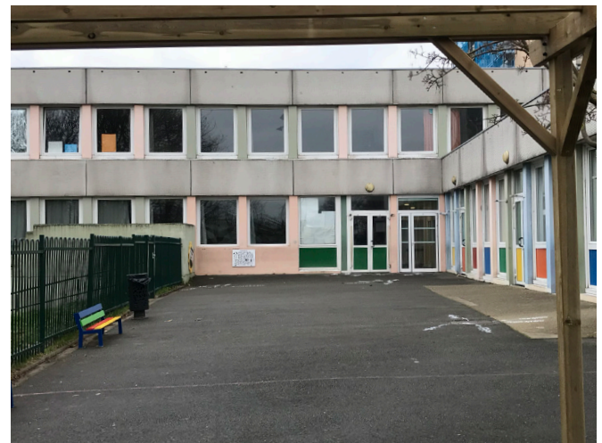
À l'arrière de la pergola, l'espace libre est réservé à la pratique du vélo.
