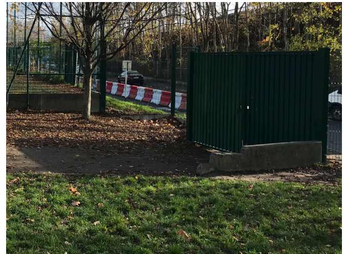
La grille qui permet l'accès pompiers est aujourd'hui utilisée comme portail principal de l'école élémentaire.
