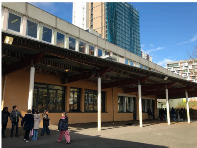
Côté bâtiment, le préau permet de s'abriter de la pluie et du soleil. Il est utilisé par les filles et les garçons.
