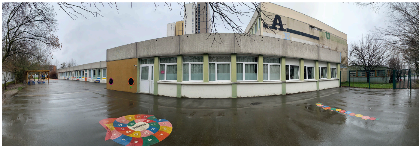
Vue panoramique de la cour depuis la partie Est. Cet espace est très traversé par les vélos, trottinettes et autres activités dynamiques.
