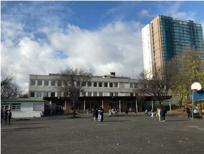
Vue d'ensemble de la cour depuis l'accès au stade. Au premier plan, le terrain est délimité par les cages et paniers de basket.
