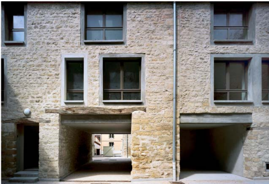
Réhabilitation d'un corps de ferme en logements sociaux à Juziers, travail d'insertion des menuiseries dans les façades d'origine et percées visuelles, Pierre Lépinay architecte, cliché Patrick Tournebœuf.
