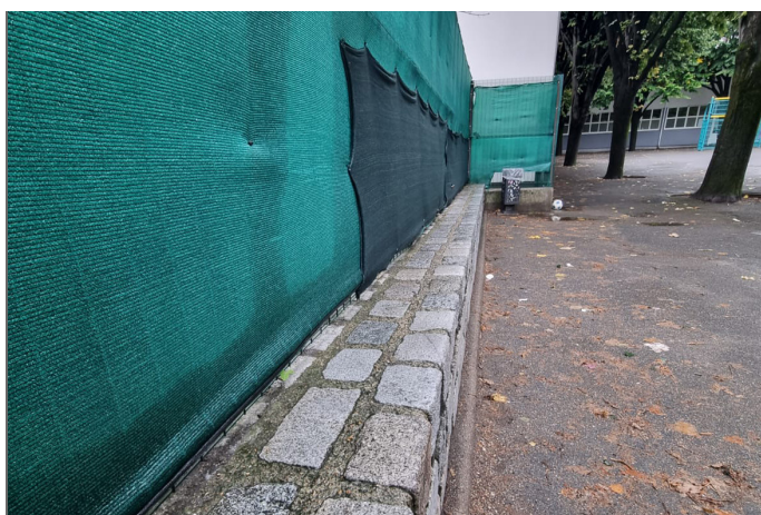
Muret maçonné utilisé comme assise, le long du jardin de la gardienne
