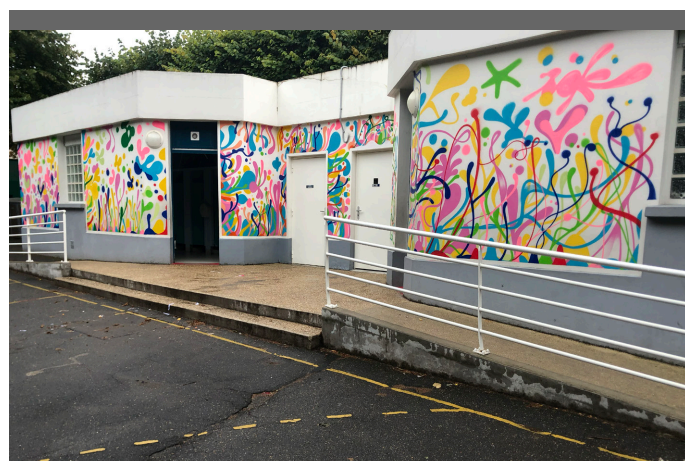
Entrées des sanitaires
