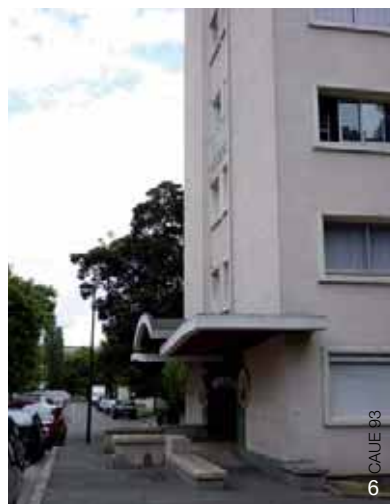
Ces entrées ont fait l'objet d'un travail de composition architecturale très soignée.
