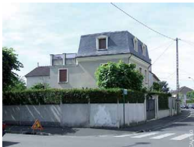
La propriété est isolée par une clôture pleine en béton doublée d'une haie de thuyas. La limite s'impose sur l'espace public au lieu de s'y fondre.
