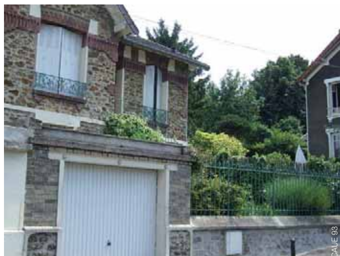
Le garage bâti sur l'alignement prolonge la clôture et joue le rôle d'interface avec la rue.
