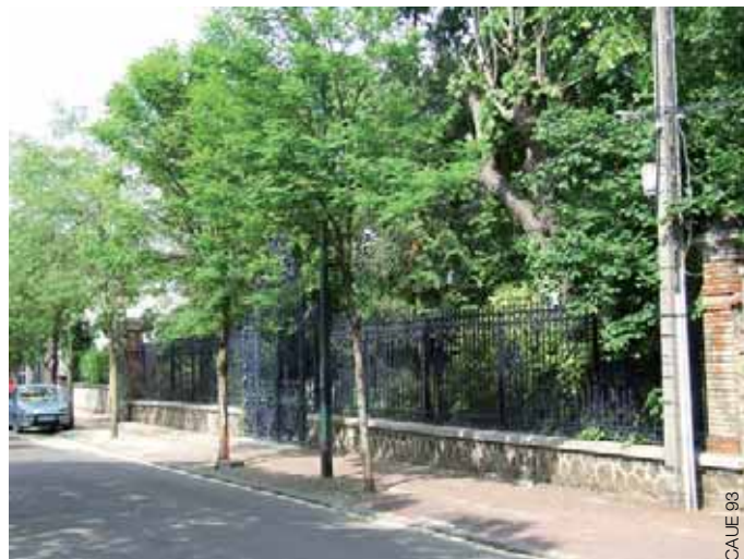
Le mur bahut en pierre rehaussé d'une grille en fer forgé conserve les caractéristiques de ce type de quartier.
