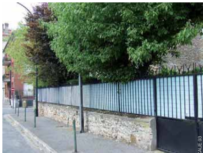
La canisse s'oppose fortement avec les matériaux traditionnels utilisés dans la clôture.
