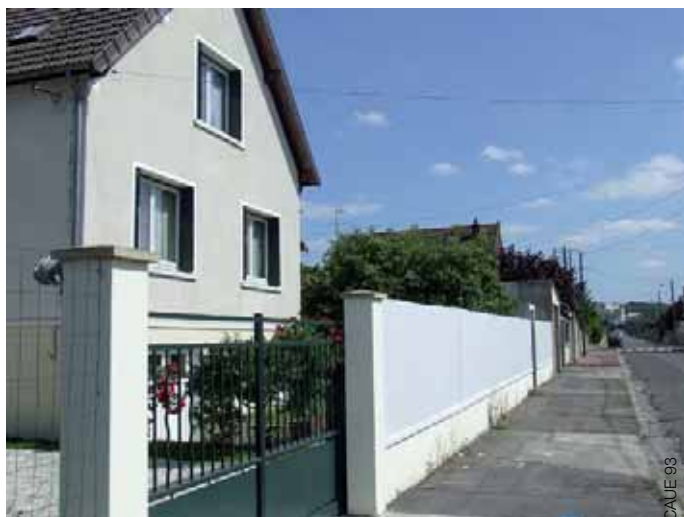
Clôture opaque en PVC blanc qui rompt le lien entre la propriété et l'espace public.
