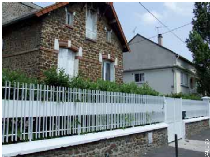
La couleur blanche met la clôture en avant par rapport au pavillon et ne contribue pas à valoriser la façade de la propriété.
