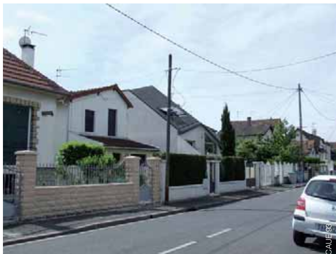
Rupture de la continuité visuelle par le décalage de matériaux et de hauteur entre les clôtures voisines.
