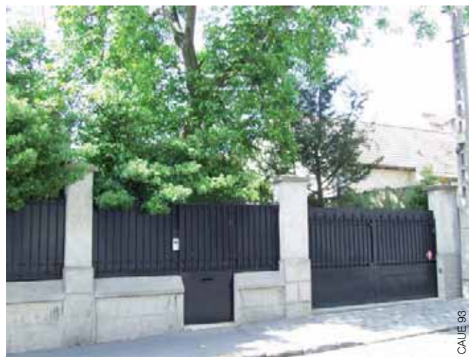
Tôles totalement occultantes en métal pour préserver l'intimité. La tôle protège des regards mais est trop haute, une occultation à mi-hauteur de la grille aurait été suffisant. De plus, ce système cache le jardin mais n'empêche pas les intrusions.
