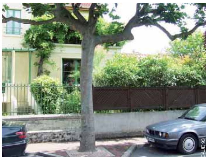
Rupture dans la continuité visuelle des clôtures mitoyennes dû au changement brusque des matériaux utilisés.
