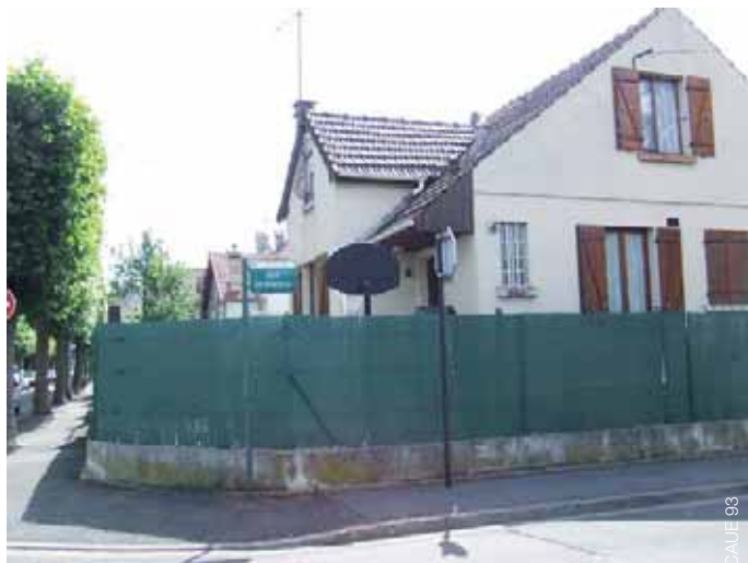
La canisse en plastique dégrade l'aspect extérieur de la maison et le caractère de l'espace public.
