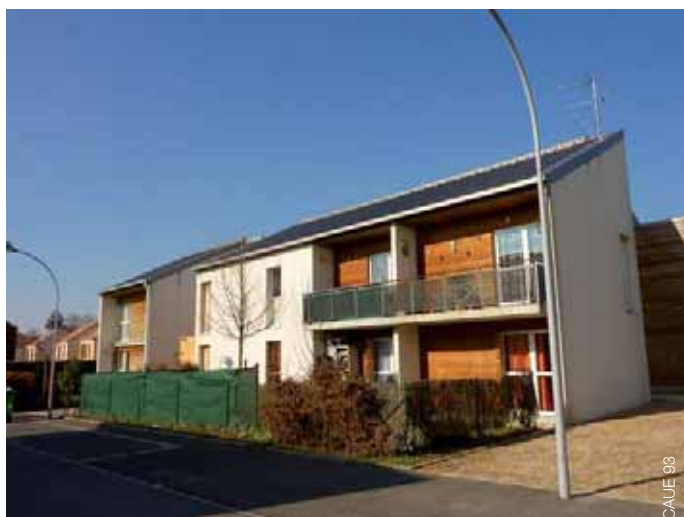
Grille souple qui délimite les jardins privés occultée par des éléments divers, ce qui casse la cohérence d'ensemble de l'opération.
